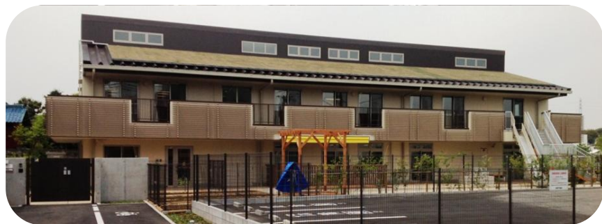
屋上緑化の取り組み（繁茂する前）
